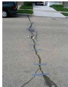
Cum să repară crăpăturile din asfalt
