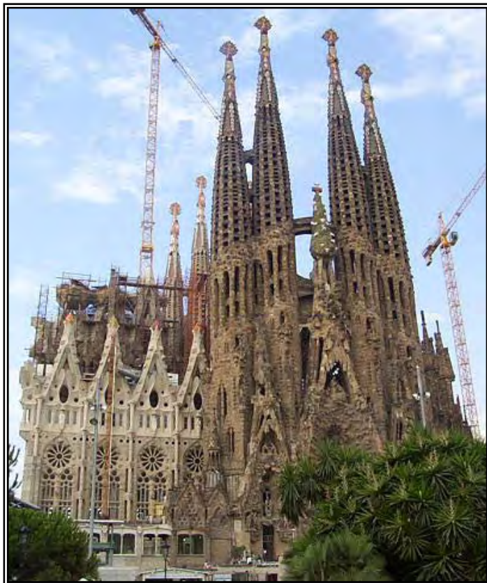
Barcelona – Sagrada Família (fațada „Nașterea Domnului”)
